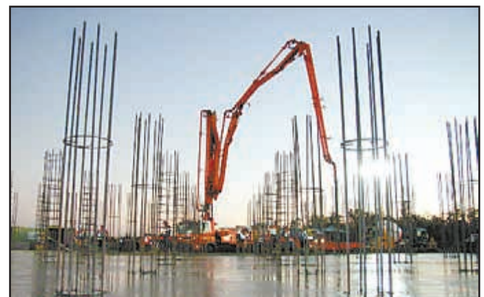
CONCRETE POUR — AMMONIUM NITRATE PLANT, MORANBAH
